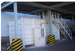
下塗工程（電着）排水の再利用水タンク
