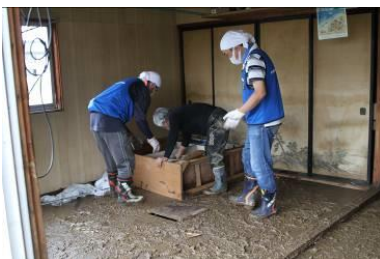
床上浸水の被害に遭った部屋の清掃
