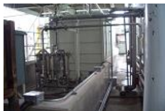
再利用水タンクへの防液堤設置
