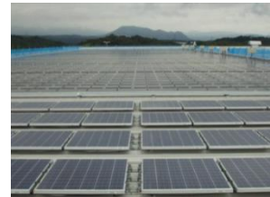
本社・宮城大衡工場 建屋屋上の太陽光パネル（最大出力：350kW）
