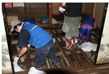
床板を剥がしてから泥を掃き出し
