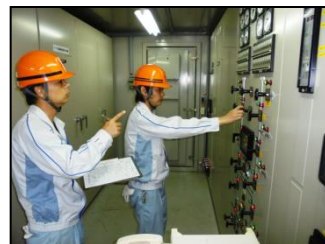
変圧器停止作業の様子
