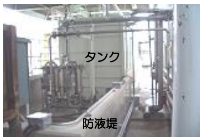
塗装工程で使用する水を再利用する ためのタンクへも万一の漏洩に備え た防液堤を設置
