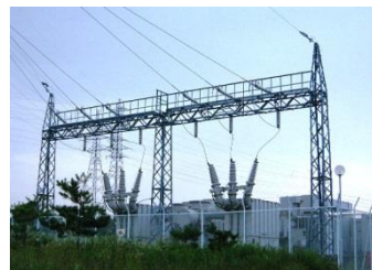
工場内変圧器
