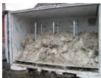
コンテナによる冷房利用
