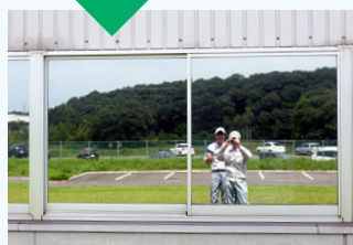
フィルム施工後(写真は外側から撮影)
