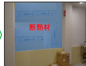
石膏ボード上に断熱材を貼付け
