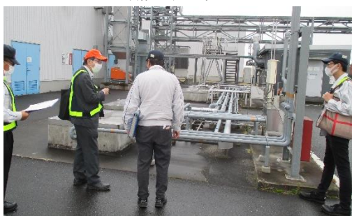
設備の現地確認
