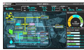
エネルギーマネジメントシステム
